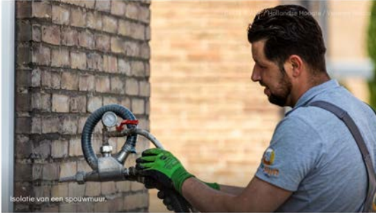
Isolatie van een spouwmuur.
